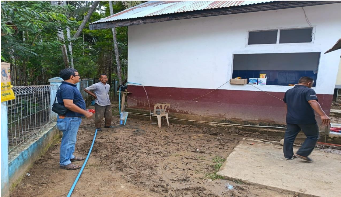
Gambar 4. Lokasi Pembangunan Sumur Bor
