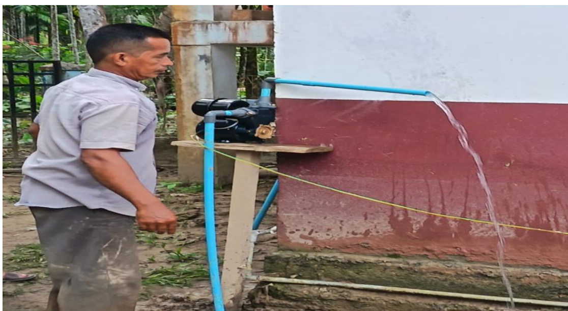
Gambar 2. Pembangunan Sumur Bor
