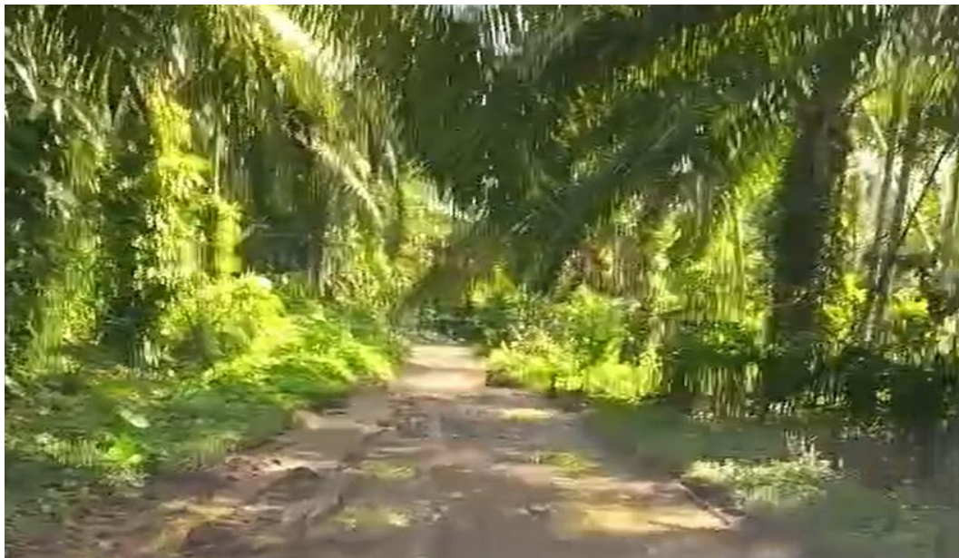
Gambar 5. Kondisi Jalan Lintas Desa Alue Leuhop
